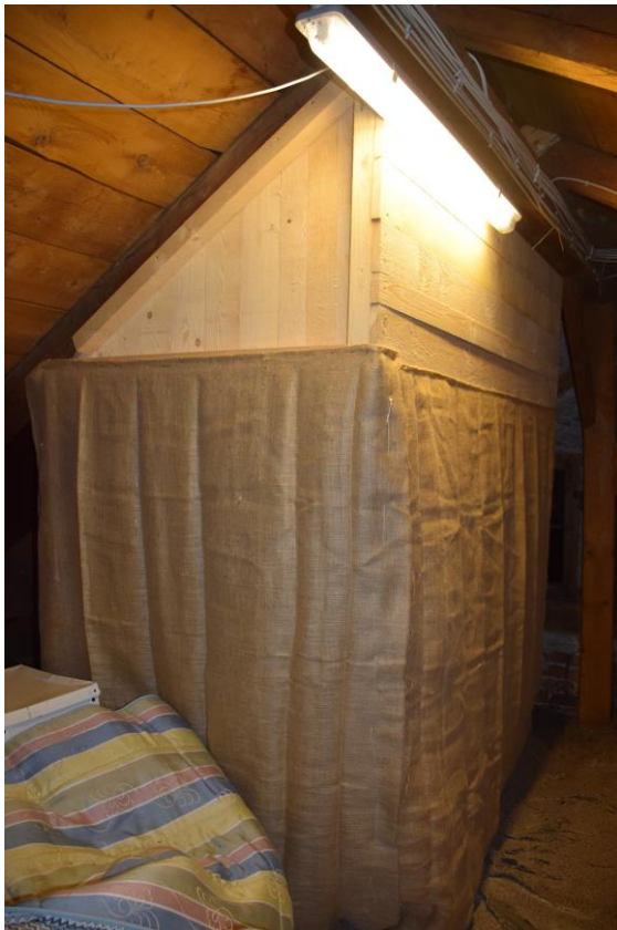
Wärmeglocke mit Stoffverlängerung im Dachboden eines Privathauses. Foto: Corinna Lieberth
